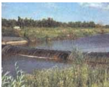
Рис. 204. Плотина из мягких тканевых материалов не наносит ущерба экологической среде
