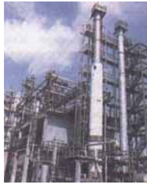
Рис. 102. Установка по переработке нефти
