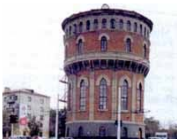
Рис. 171. Бывшая водонапорная башня в Оренбурге, памятник архитектуры 1927-1928 гг.
