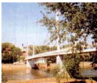
Рис. 196. Пешеходный мост через р. Урал (Оренбург)
